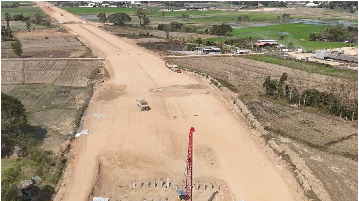
รูปที่ 5-3 ช่วง กม.1+000 (พื้นที่ก่อสร้างถนนสายแยก ทล.11 ถึง ทล.1 อ.เมือง จ.ลำปาง ตอนที่ 1 อยู่ระหว่างดำเนินการก่อสร้าง)
