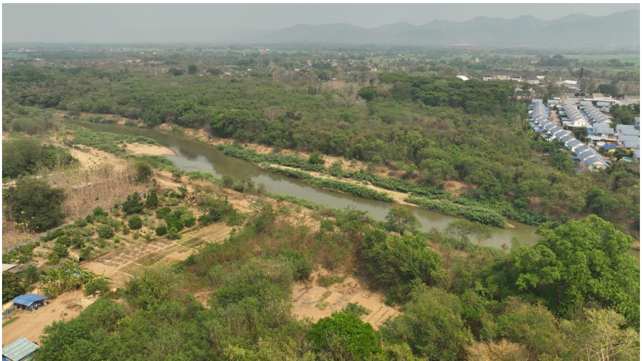
รูปที่ 5-17 ช่วง กม.12+988 ผ่านพื้นที่เกษตรกรรม และตัดผ่านแม่น้ำวัง (แนวถนนสายแยก ทล.11 ถึง ทล.1 อ.เมือง จ.ลำปาง ตอนที่ 2)
