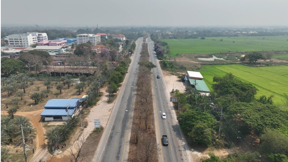
รูปที่ 5-38 สภาพพื้นที่แนวสายทางบริเวณทางหลวงหมายเลข 1 (กม.2+000)
